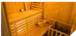
Iluminación bajo el banco
